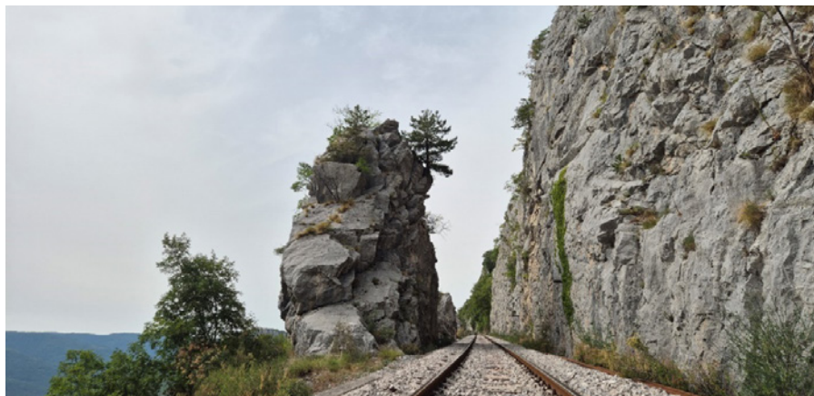
Detalj usjeka pruge nedaleko od Buzeta, snimio Matija Nežić. Dettaglio del tratto in trincea della linea ferroviaria nei pressi di Pinguento, foto Matija Nežić.
